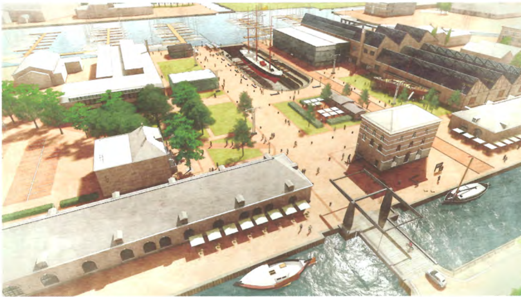
Op de voormalige marinewerf Willemsoord wordt onder meer een iepenlaantje – in de volksmond het 'schuine pad' – hersteld. / Among the improvements in the former Willemsoord naval dockyard is the restoration of an avenue of elms.
